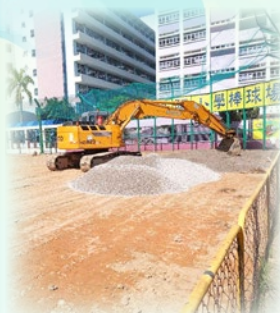
棒球場翻新工程於 2022 年 2 月正式動工，先要平整泥地，增加去水度
